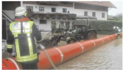
Im Hochwasser-Katastrophenfall sind die Willinger Feuerwehrler mit dem mobilen Hochwasserschutzsystem „Floodtube“ im Einsatz.
